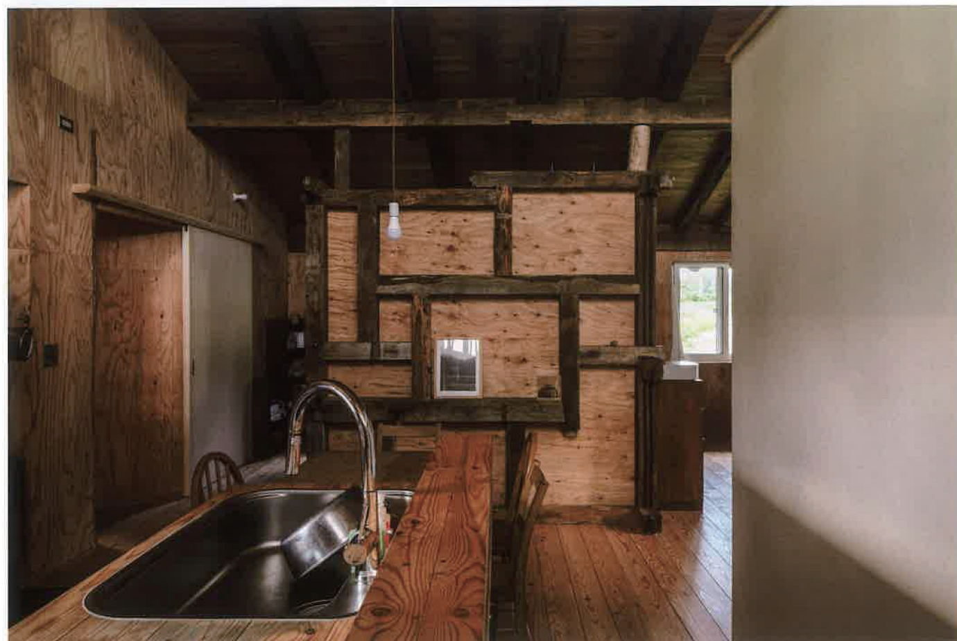
尺の短い古材は、縦ぎ合わせて「校倉(あぜくら)」と名付けた収納に生かした。この地に織のある古材が、新居の個性として表現されている
