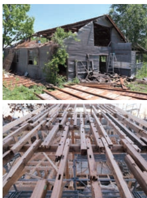
上：解体中の牛舎。 下：牛舎のあった場所に新築。牛舎の古材ありきで設計を行ったため、古材が不均一に並ぶ。
