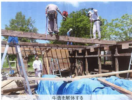
牛舎を解体する
