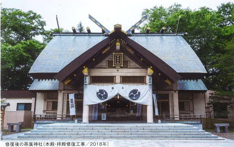
修復後の帯廣神社(本殿・拝殿修復工事/2018年)
